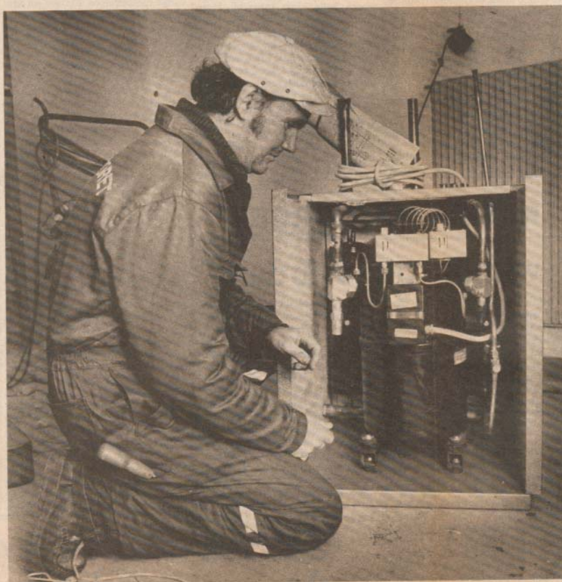
Värmepumpen Octopus håller på att installeras i Hässleholms vattenverk, för verkets egen värmeförsörjning. Maskinisten Tryggve Rasmussen visar pumpen och berättar att den enbart kommer att ta energi ur vatten.
